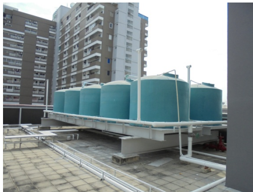
ภาพที่ 4-8 ถังสํารองน้ำชั้นดาดฟ้า
