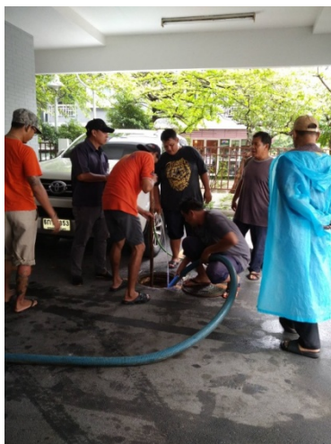
ภาพที่ 4-33 ดูดตะกอนบ่อเกรอะ
