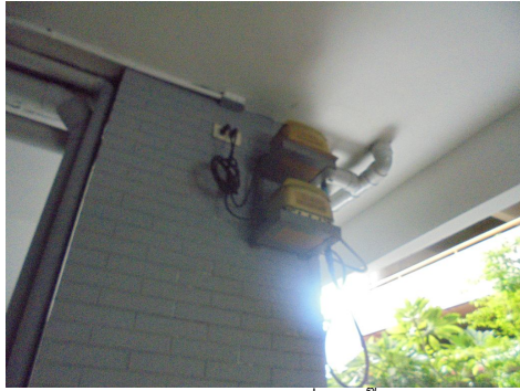
ภาพที่ 4-3 บั้มเติมอากาศในระบบบำบัดน้ำเสียแต่ละส่วน
