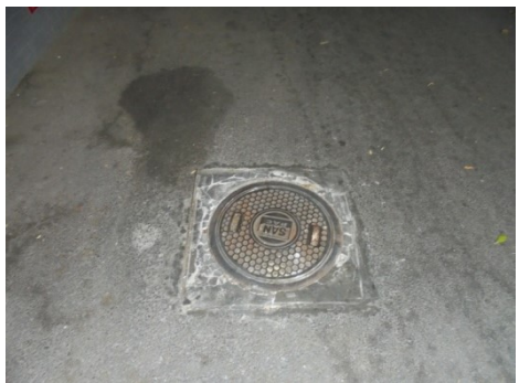
ภาพที่ 4-5 ฝาถังตกตะกอนและบ่อพักน้ำทิ้งก่อนปล่อยออกสู่ท่อระบายสาธารณะ
