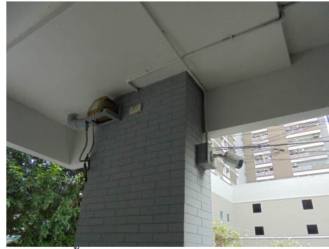
ภาพที่ 4-3 บั้มเติมอากาศในระบบบำบัดน้ำเสียแต่ละส่วน
