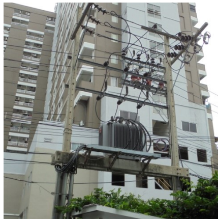
ภาพที่ 4-19 หม้อแปลงไฟฟ้าแยกจากชุมชน
